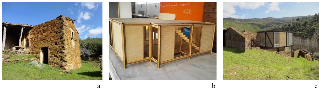
Figura 2. Intervención con la modulación en acero para la rehabilitación de edificios en xisto. (a) ruina, (b) modelo del prototipo, (c) visualización de la intervención a través de la modelación 3D (fotografía del archivo de los autores).
