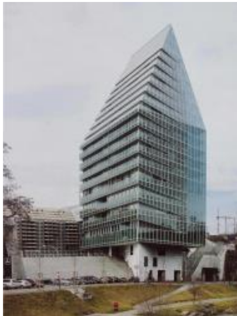
Figura 17. Herzog & de Meuron. Torre St. Jakob en Basilea, Suiza. 2003-08.
