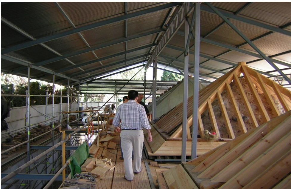
Figura 5. Visita a las obras de restauración de las cubiertas del Palacio de Leones de la Alhambra durante el módulo de Materialidad del Marph, año 2007.
