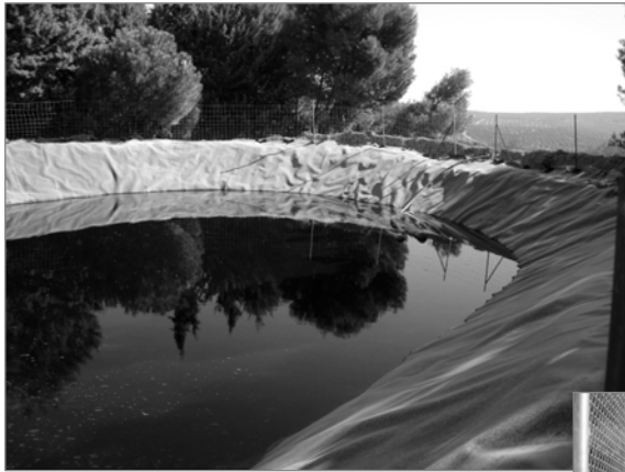
Balsa de aguas de lavado de aceitunas
