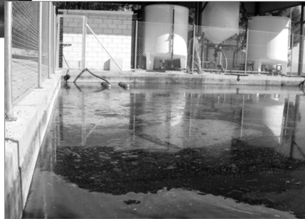
Balsa de aguas de lavado de aceite.
