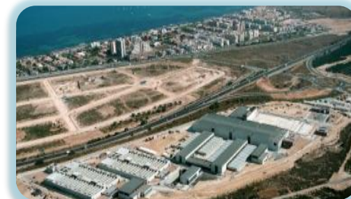
Desaladora de Torrevieja (Alicante)
