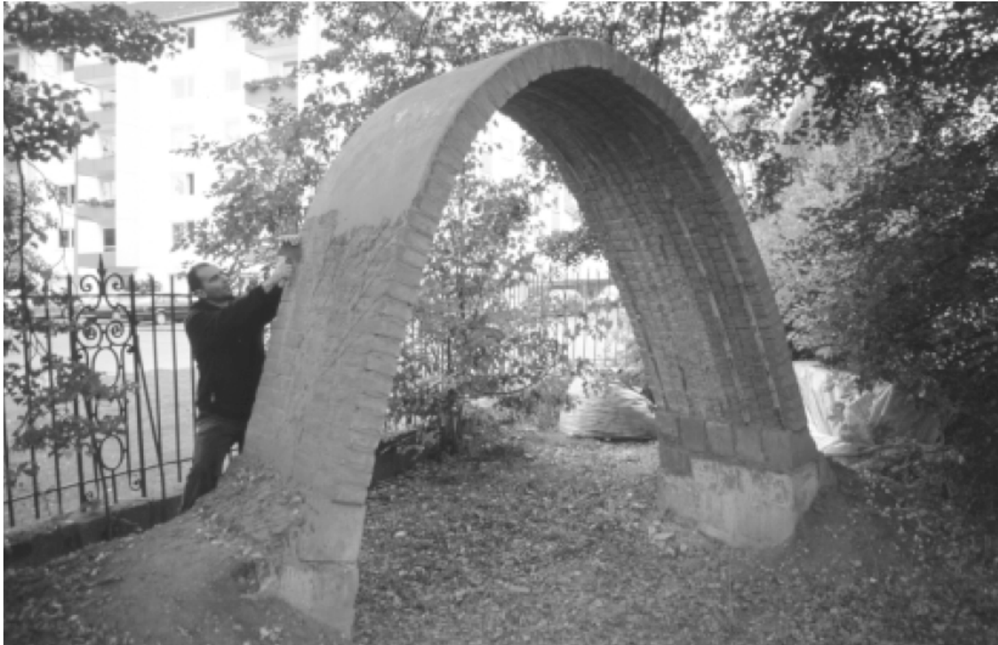
Bóveda antisísmica de adobe reforzado con bambú
