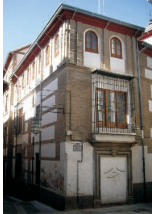
Fig. 4. Fachada y puerta cegada del hospital.
