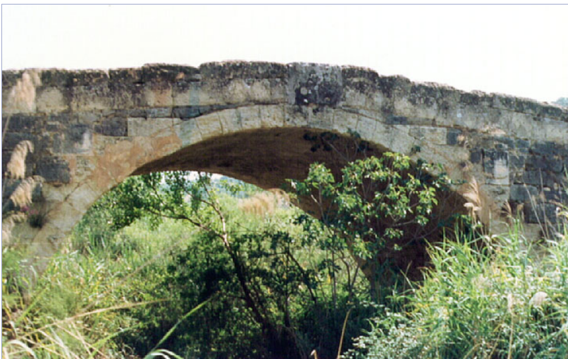
Lámina III. Puente sobre el arroyo Salado en el km. 6 de la carretera Martos-Fuensanta. Fotografía autor.
