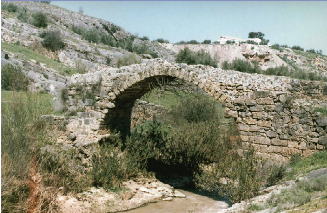
Lámina IV. Puente sobre el río Víboras en la carretera Martos-Alcaudete. Fotografía autor.
