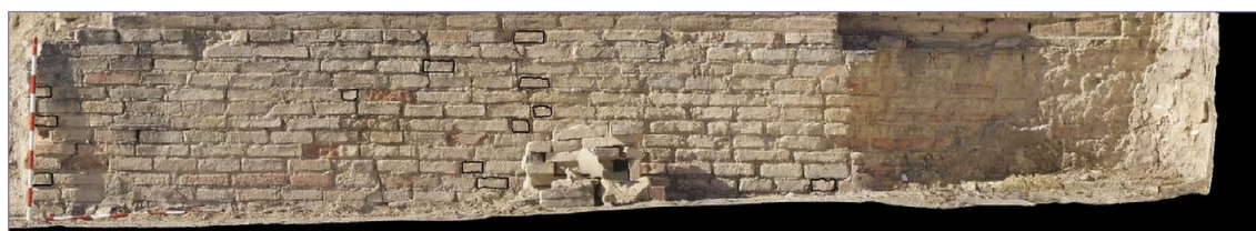
Fig. 7. Ladrillos recortados en la estancia XX.
