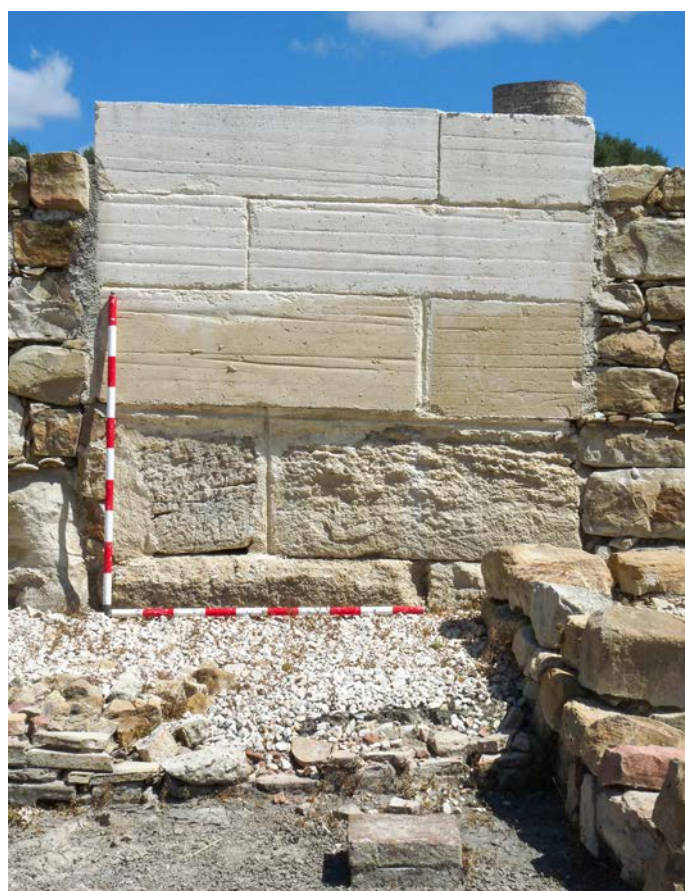
Figs. 2-3. Muro de cierre del Pórtico Sur: bloques de piedra caliza local y opus vittatum.
