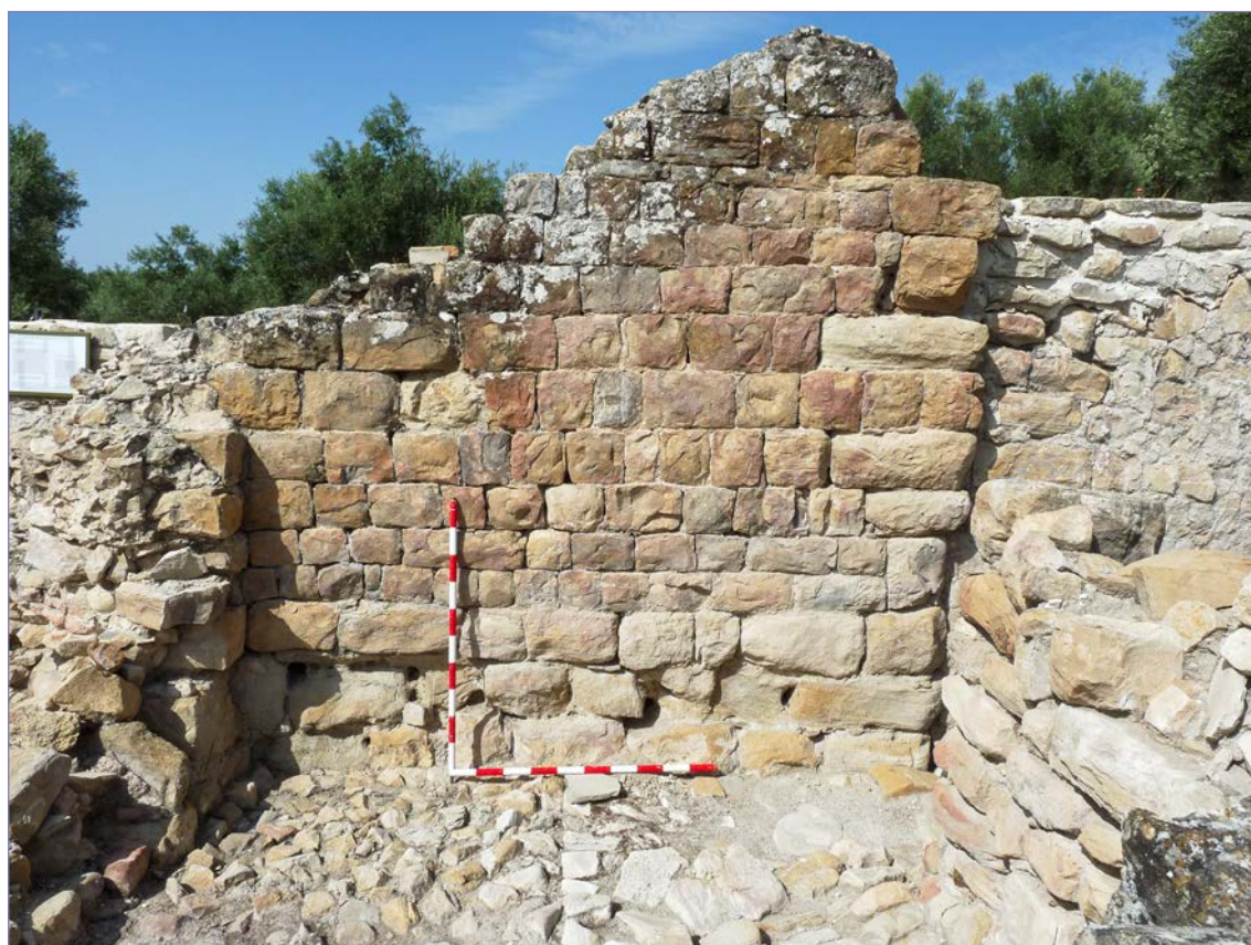
Fig. 9. Alzado de muro conservado en opus vittatum .
