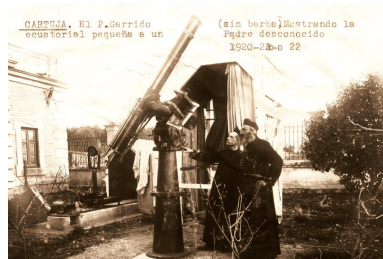
El refractor Mailhat con dos astrónomos jesuitas (el padre Garrido y un desconocido) en el Observatorio de Cartuja (c. 1921). Puede verse la cámara fotográfica asociada a uno de los buscadores, así como la cobertura auxiliar para la realización de las fotos. (Crédito: Instituto Andaluz de Geofísica)
