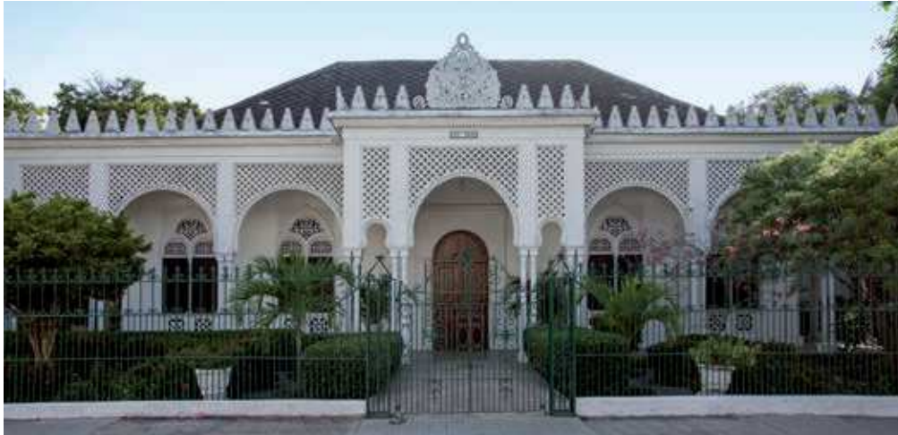
Casa Covo / Barrio Manga, Cartagena de Indias, Colombia. Construcción 1918-1920 y decoración hasta 1931
