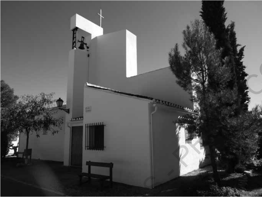
Lámina 16. Iglesia de Cañatalba Alta (foto J. M. Barrios).
