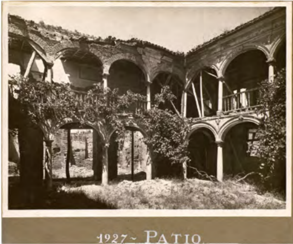
Torres Molina, Manuel. (atrib. fot.). [Claustro del convento de San Francisco, antes y después de su restauración]. 1927 - 1929. Positivos sobre papel montados sobre cartulina para su exposición. Archivo de la Alhambra, F-21295 y F-21303
