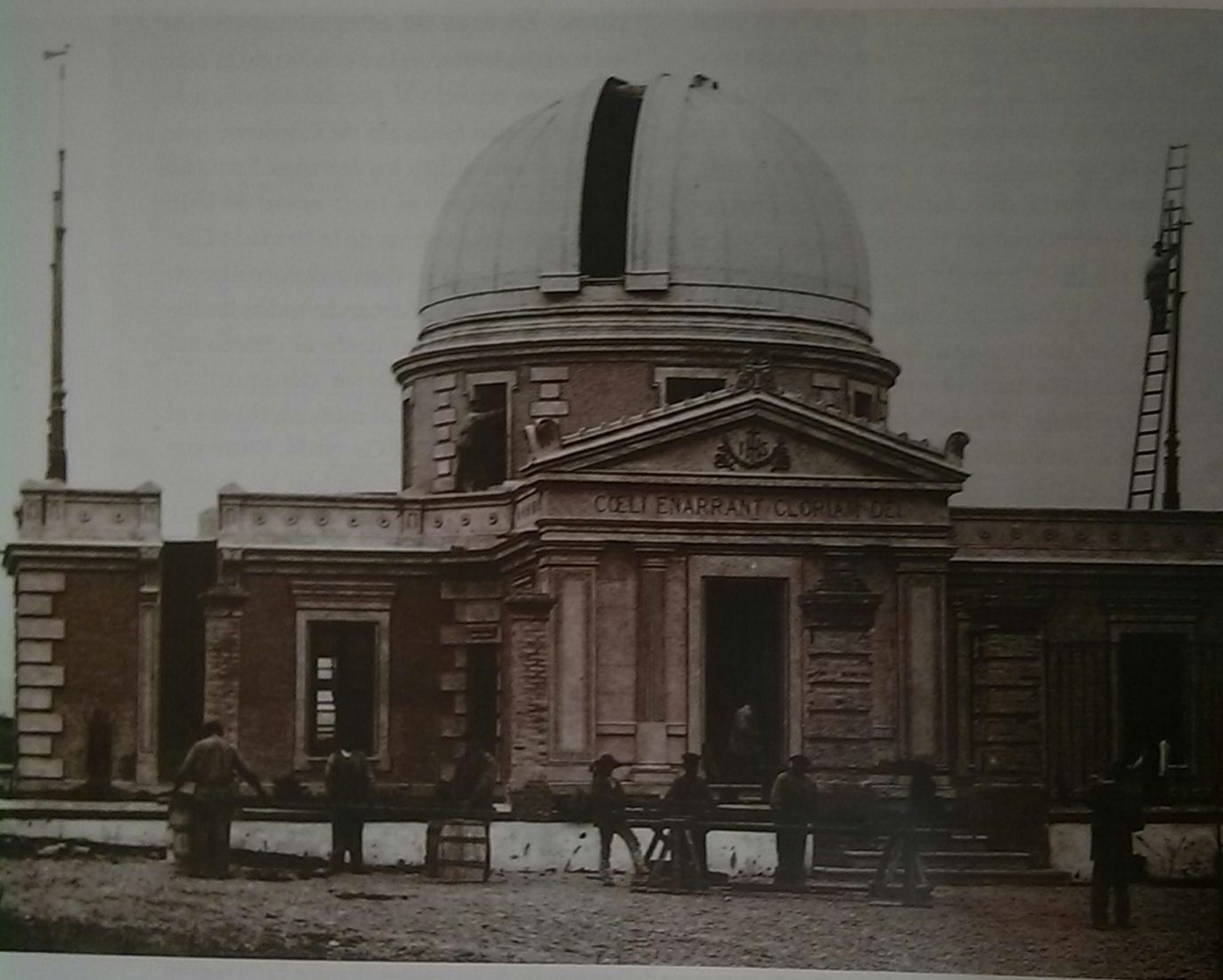
Observatorio Cartuja en construcción.
