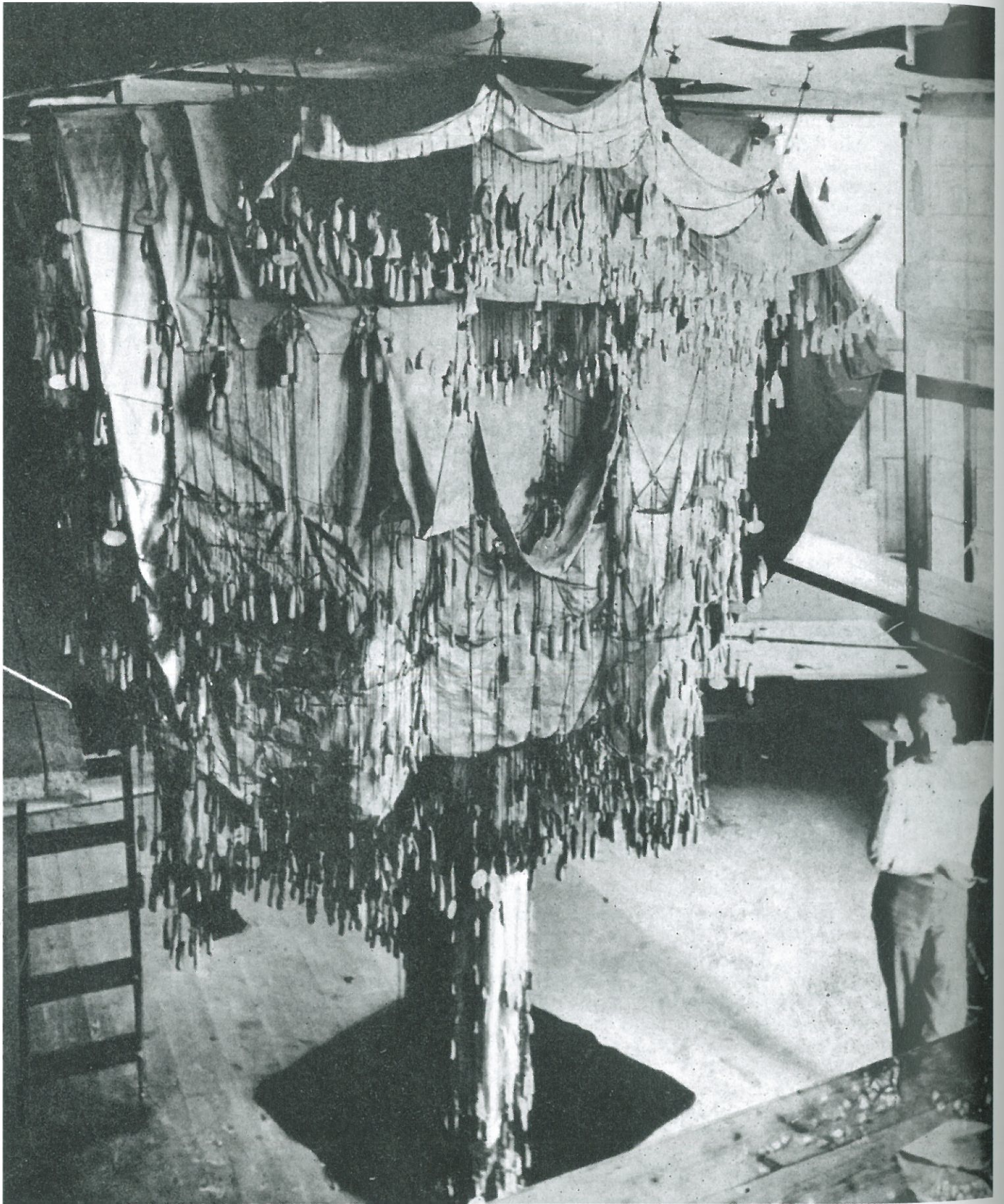
4 Antoni Gaudí, Modell für das Gewölbe der Krypta der Colònia Güell, um 1908
