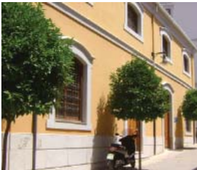
Entrada principal a las instalaciones de la Unidad Técnica en el Complejo Triunfo
