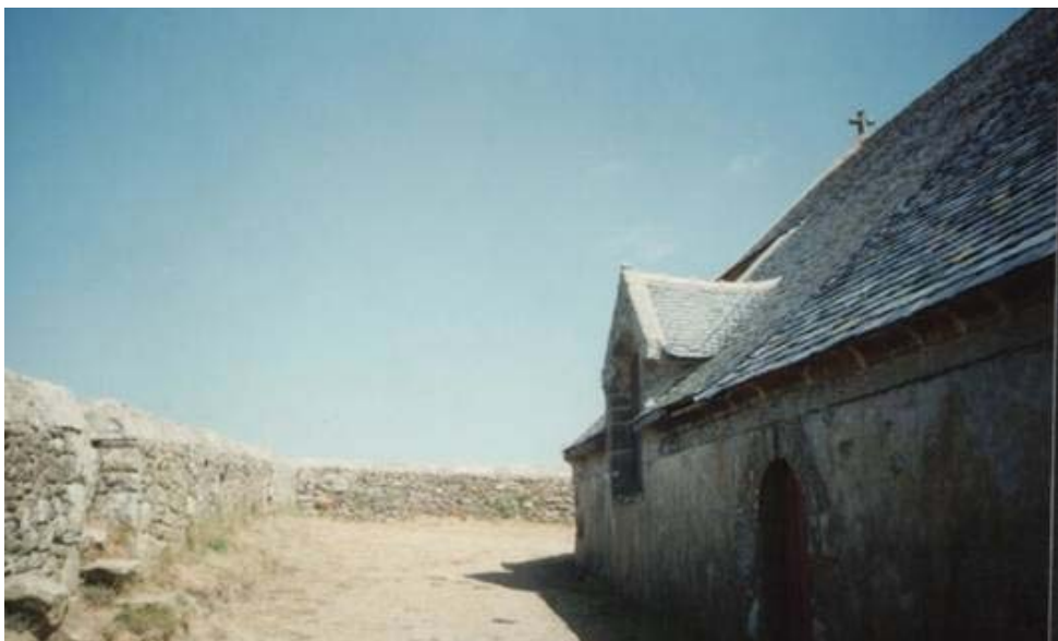
Figura 12: Fachada Norte, con su entrada.
