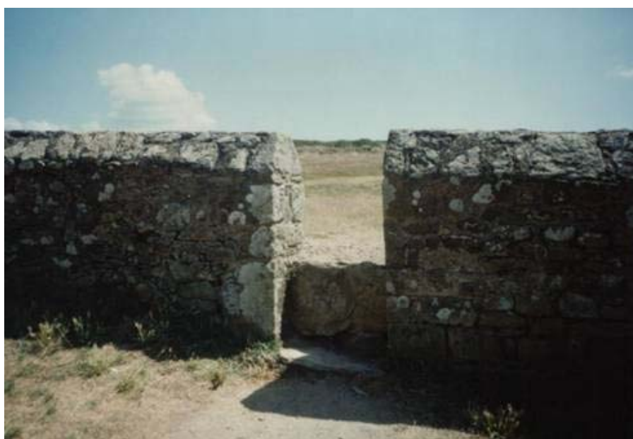
Figura 14: Muro del recinto. Entrada Sur.
