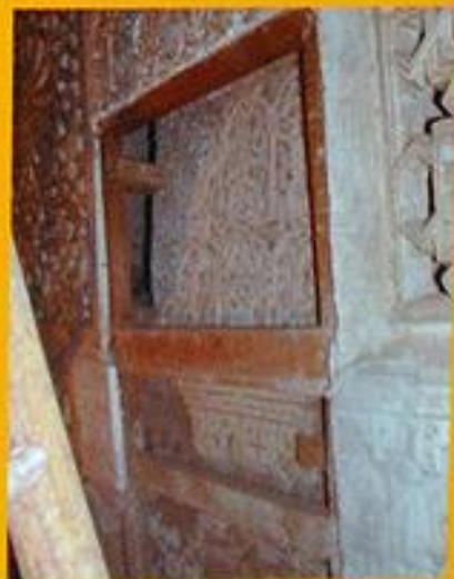
Yesería moderna sobrepuesta.
