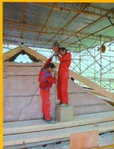
Anclado de un zuncho a los muros.
