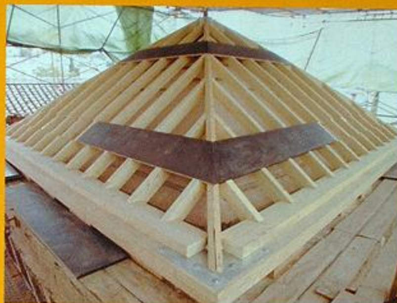
Estructura nueva de la cubierta.
