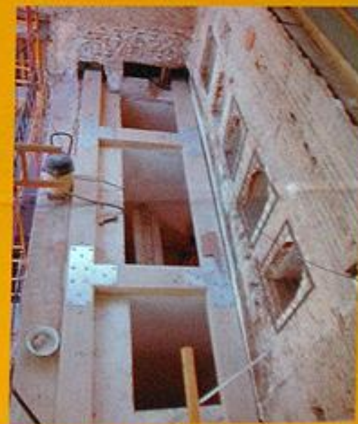
Zuncho de atado de los muros.
