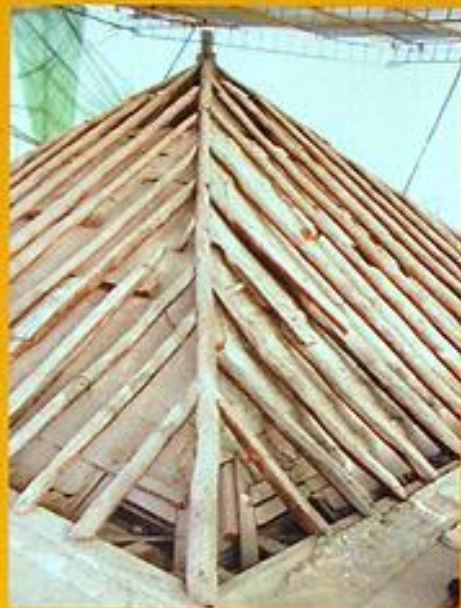
Estado de la estructura de la cubierta.
