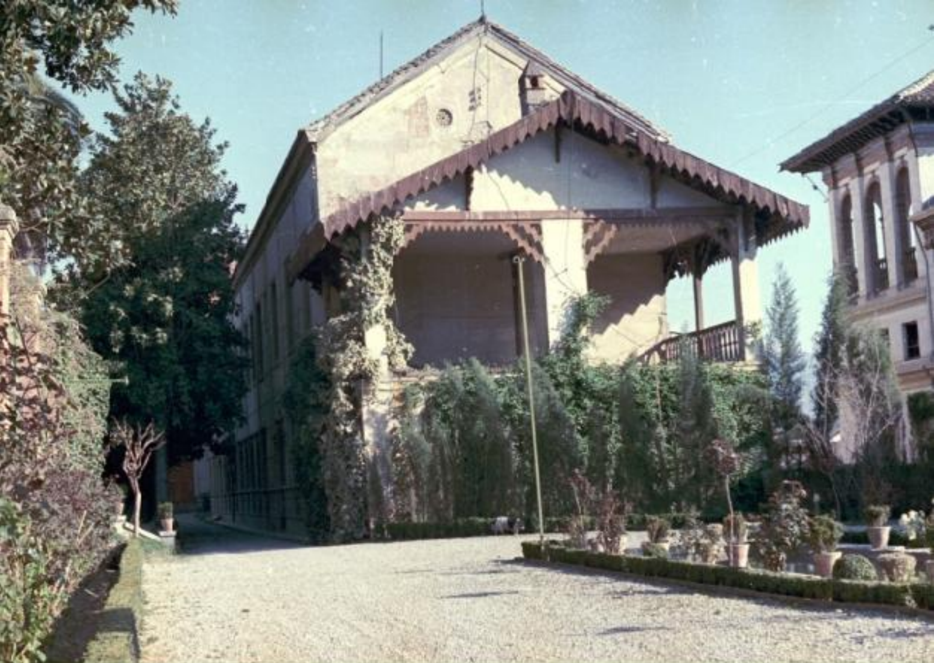
La vivienda antes de 1966.
