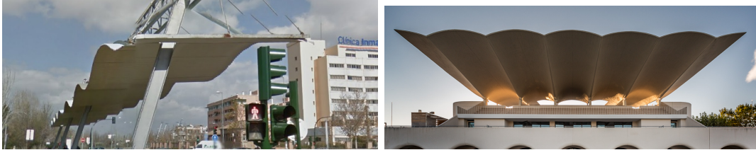
Figura 1: Cubierta parasol en Avenida Eudoxia Piriz, Granada (© Google Maps ) e Hipódromo de la Zarzuela, Madrid (Eduardo Torroja).
