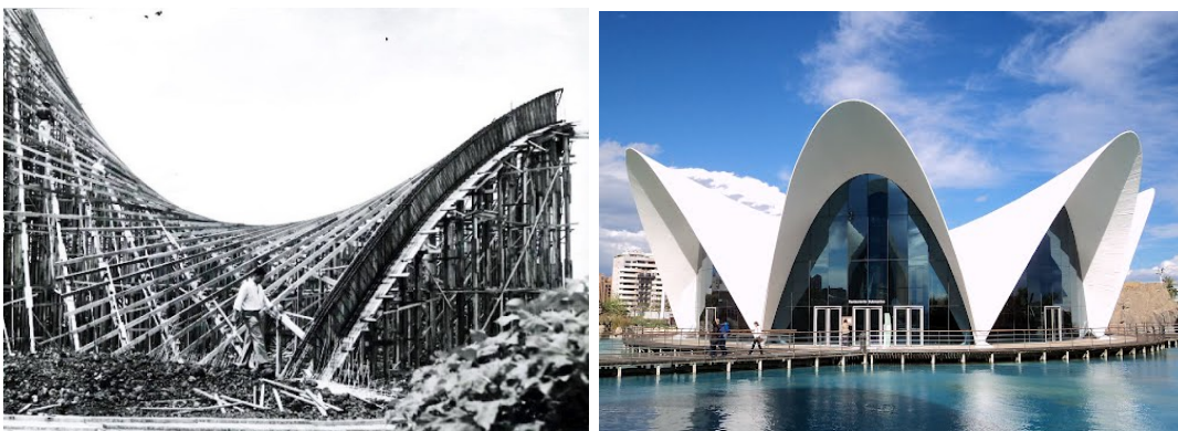
Figura 3: Cubiertas de Félix Candela. Construcción Xochimilco Restaurant y Oceanográfico de Valencia
