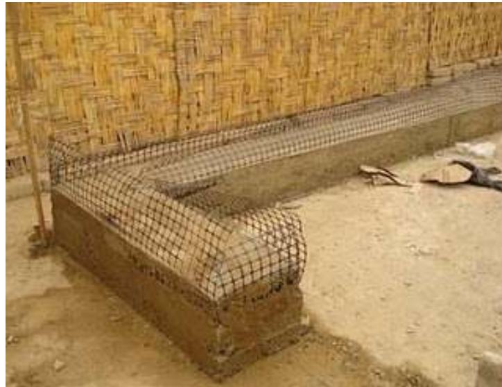
Figura AII.4: Detalle de la continuidad de la malla de refuerzo entre la cimentación y un muro en adobe (J. Kuroiva et al, 2007).
