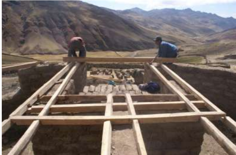
Figura AII.9: Ejecución de una viga collar en una construcción de adobe (Fuente: www. http://imageshack.us ).
