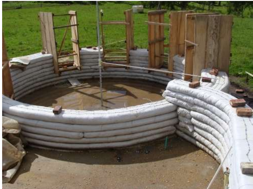
Figura V.8: Fase de construcción de una casa en superadobe (Fuente: www.calearth.com ).
