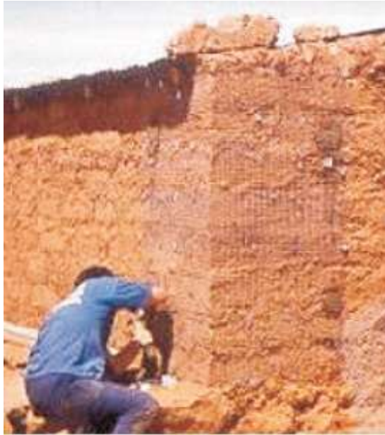
Figura AII.6: Puesta en obra de malla electrosoldada (J. Kuroiva et al, 2007).
