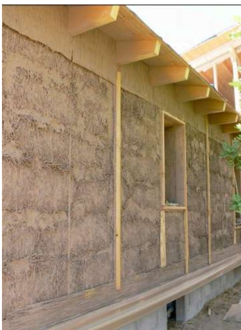
Figura V.3: Construcción de una casa con balas de paja en muros con estructura de madera en Mallorca (Fuente: www.casasdepaja.org ).
