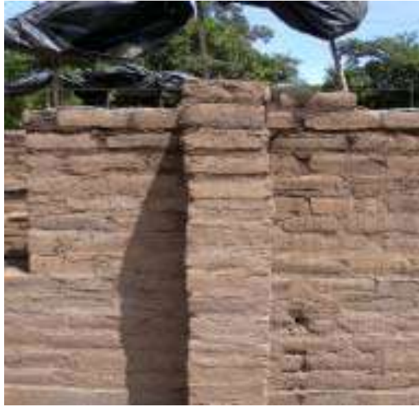
Figura AII.8: Pilastra en muro de adobe en El Salvador (M. Blondet, G-Villar García M., S. Brzev, 2003).
