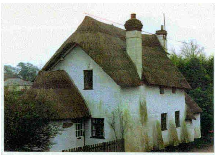
Figura 13. Casa realizada con arcilla aligerada con paja (Fuente: www.ecoaldeas.com ).
