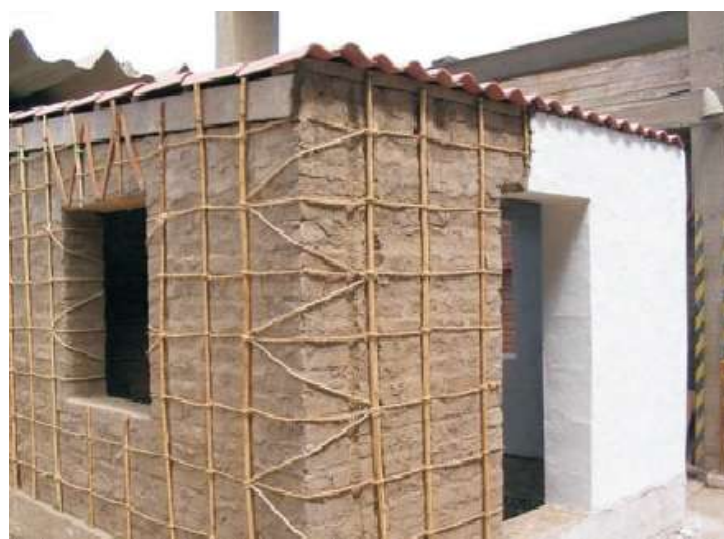
Figura AII.5: Vivienda en adobe con refuerzo mediante cañas en interior y exterior (J. Kuroiva et al, 2007).
