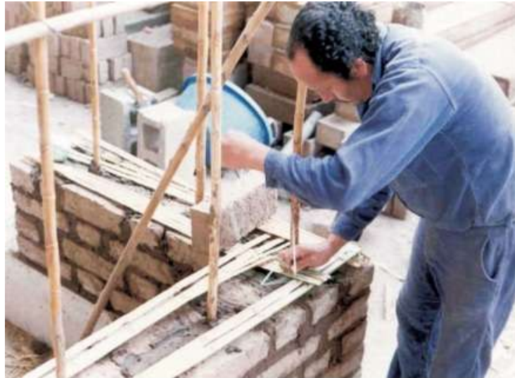
Figura AII.3: Puesta en obra de adobe reforzado con caña interconectada con hilos de nylon (M. Blondet, G-Villar García M., S. Brzev, 2003).
