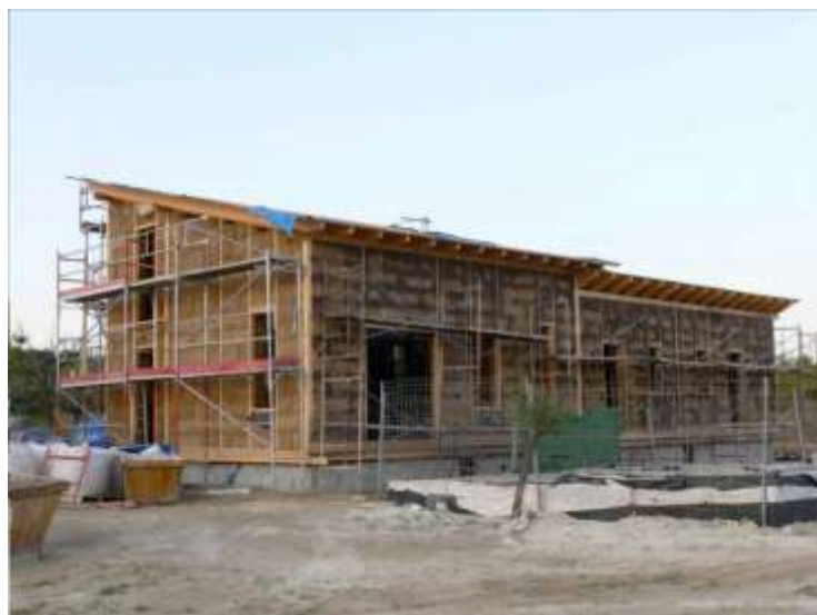
Figura V.4: Construcción de una casa con balas de paja en muros con estructura de madera en Mallorca (Fuente: www.casasdepaja.org ).
