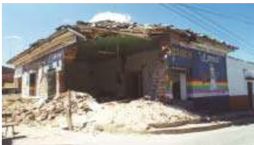
Figura AII.2: Colapso de muro de adobe, terremoto de 2001 en El Salvador (M. Blondet, G-Villar García M., S. Brzev, 2003).
