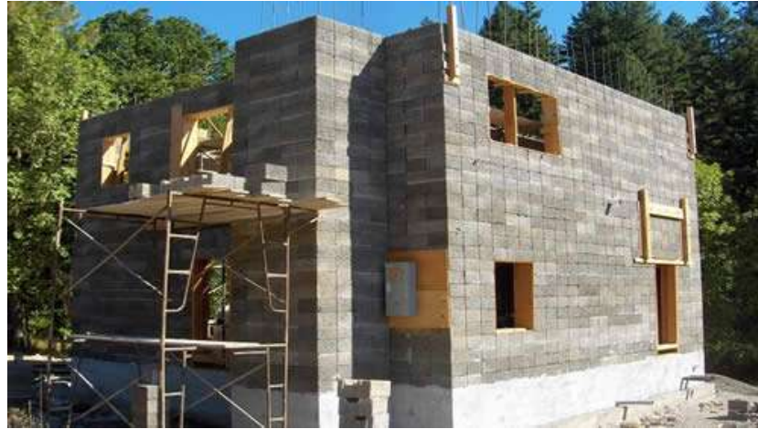
Figura V.15: Construcción de una vivienda con faswall (Fuente: www.faswall.com ).
