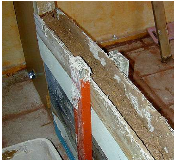
Figura 12. Puesta en obra de arcilla aligerada con paja (Fuente: www.ecoaldeas.com ).
