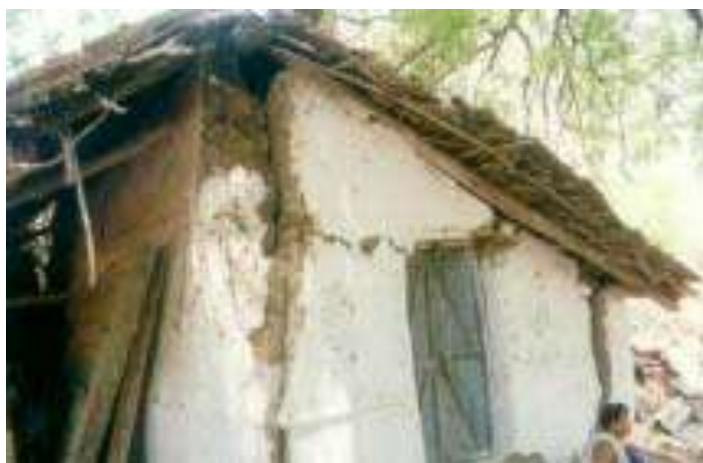
Figura AII.1: Agrietamiento y separación en muro de adobe, terremoto de 1997 en Jabalpur, India (M. Blondet, G-Villar García M., S. Brzev, 2003).
