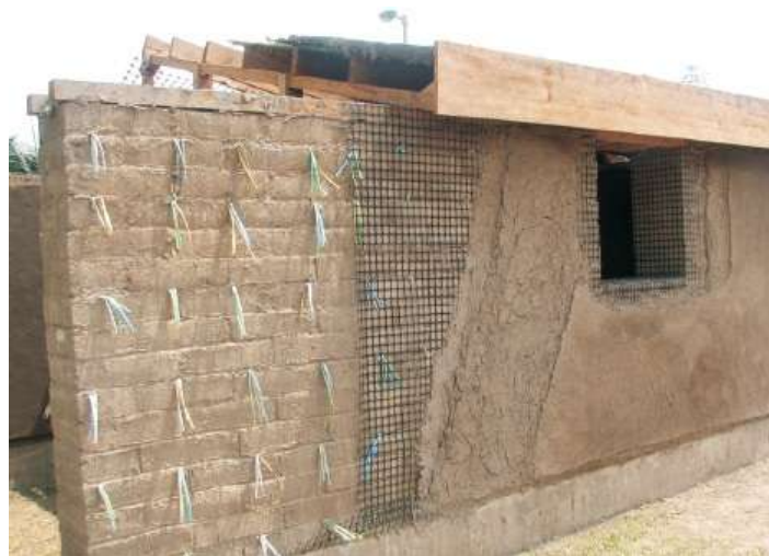
Figura AII.7: Construcción en adobe con refuerzo de malla de polímero (J. Kuroiva et al, 2007).
