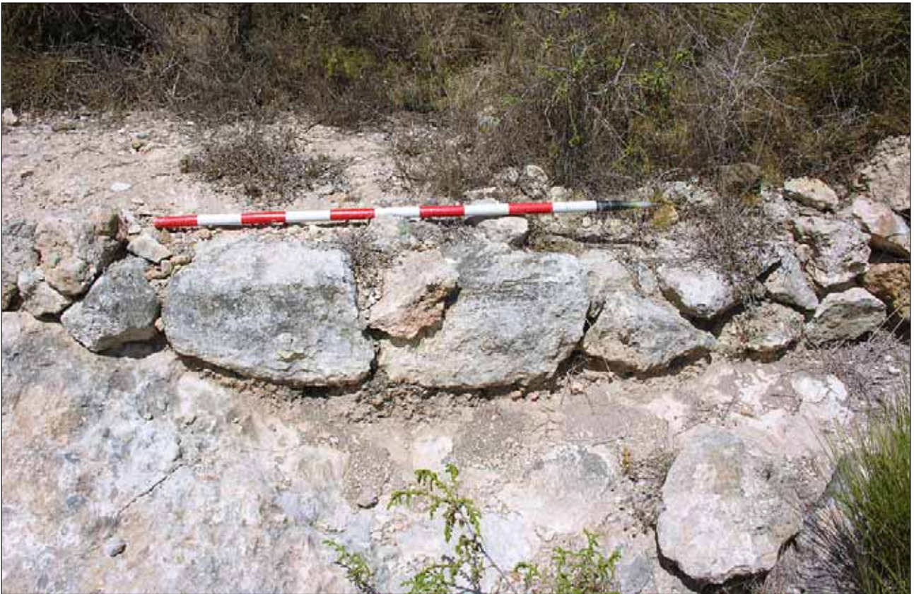
Lám. 5. Estructura de mampuestos sobre la base geológica
