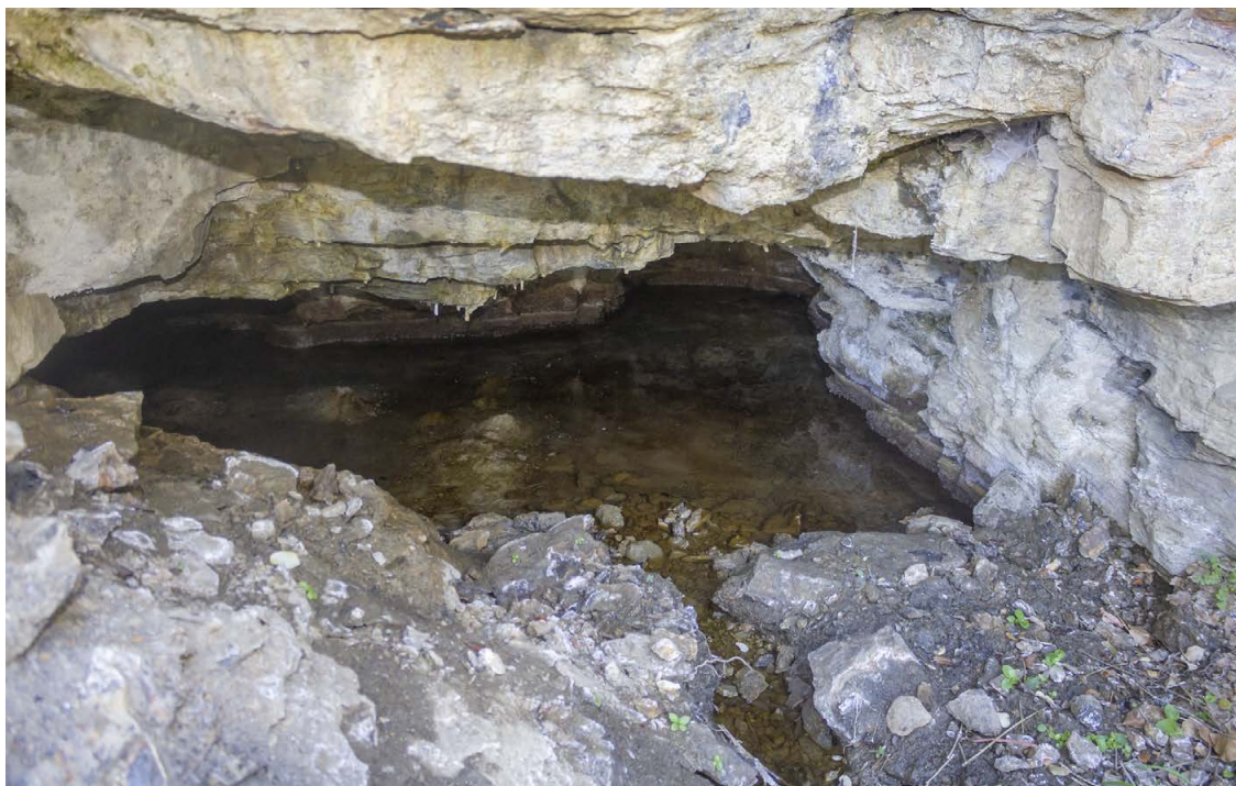
Fig. 6. Mina de agua simple en el cortijo La Fragua, a modo de apertura en la roca hasta alcanzar el nivel freático y canalizada hacia una alberca exterior. Fotografía del autor
