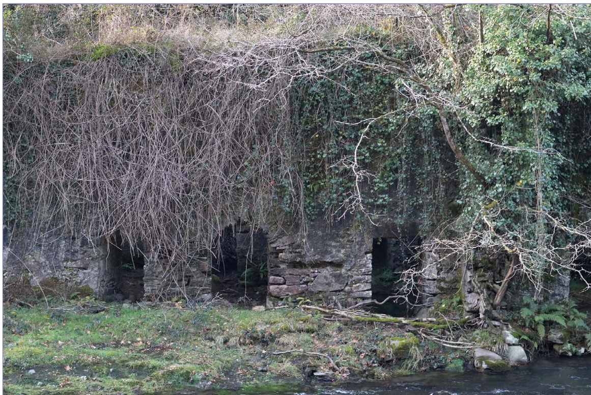
Fig. 9. La ferrería de Ibero vista desde el exterior. Fuente: elaboración propia.
