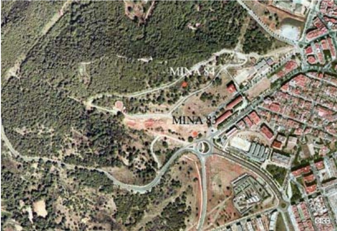
Figura 1. Fotografía aérea del sector sierra de las Ferreres y de las parcelas en las que se ha trabajado con indicación de las minas 83 y 84.
