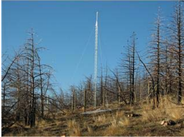
Fig 2.14. Fotografía de la torre instalada en el tratamiento de control
