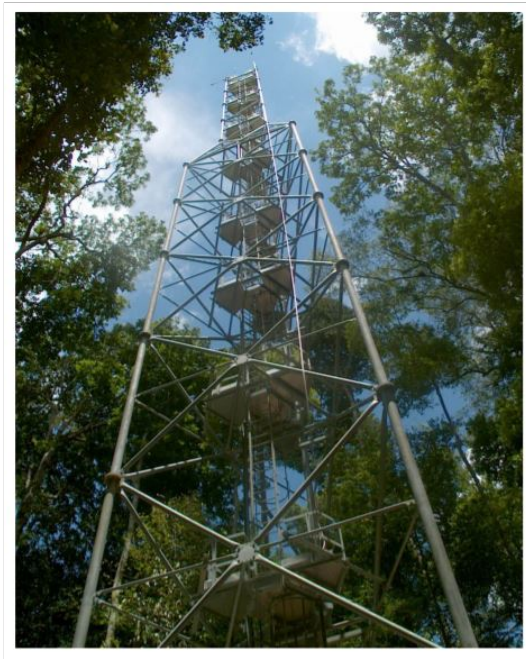
Figura 2.5: Torre de medición micrometeorológica de la estación Guyaflux ( Bonal y Burban, 2019 ).
