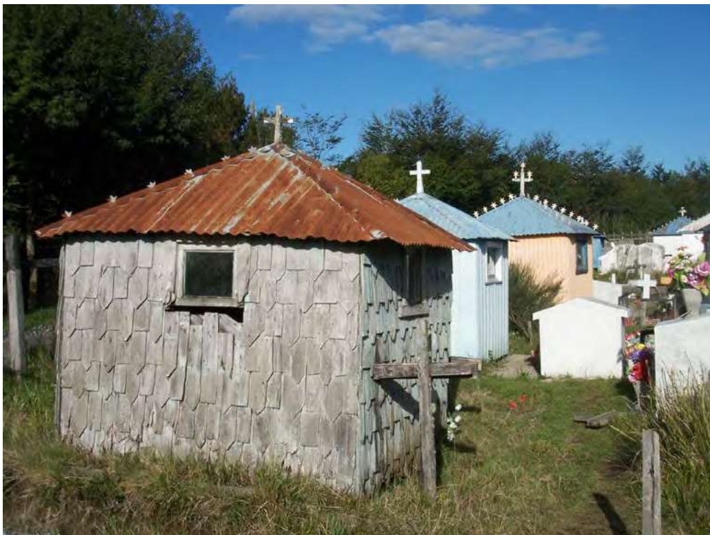
Fig. 4. Panteones construidos con los materiales típicos de la arquitectura de Chiloé. Cementerio de Teupa, Chiloé (Chile). Foto: Rodrigo Gutiérrez Viñuales, octubre de 2013.
