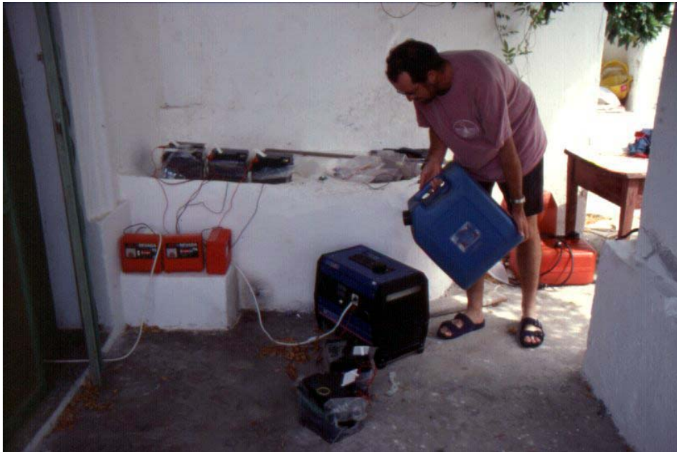
Figura 4.9. Recarga de baterías mediante un generador de gasolina.
