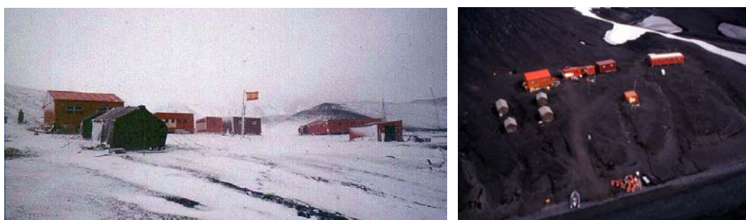
Figura 4.16. Dos vistas de la base Gabriel de Castilla, en la isla Decepción.
