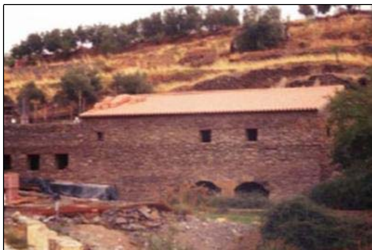
Ilustración 17. Molino rehabilitado, en Huéneja.
