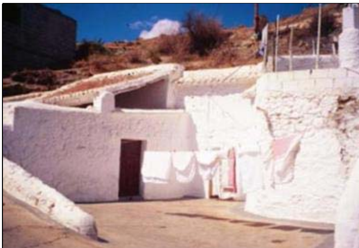
Ilustración 6. Fachada de vivienda troglodite en Fonelas.
