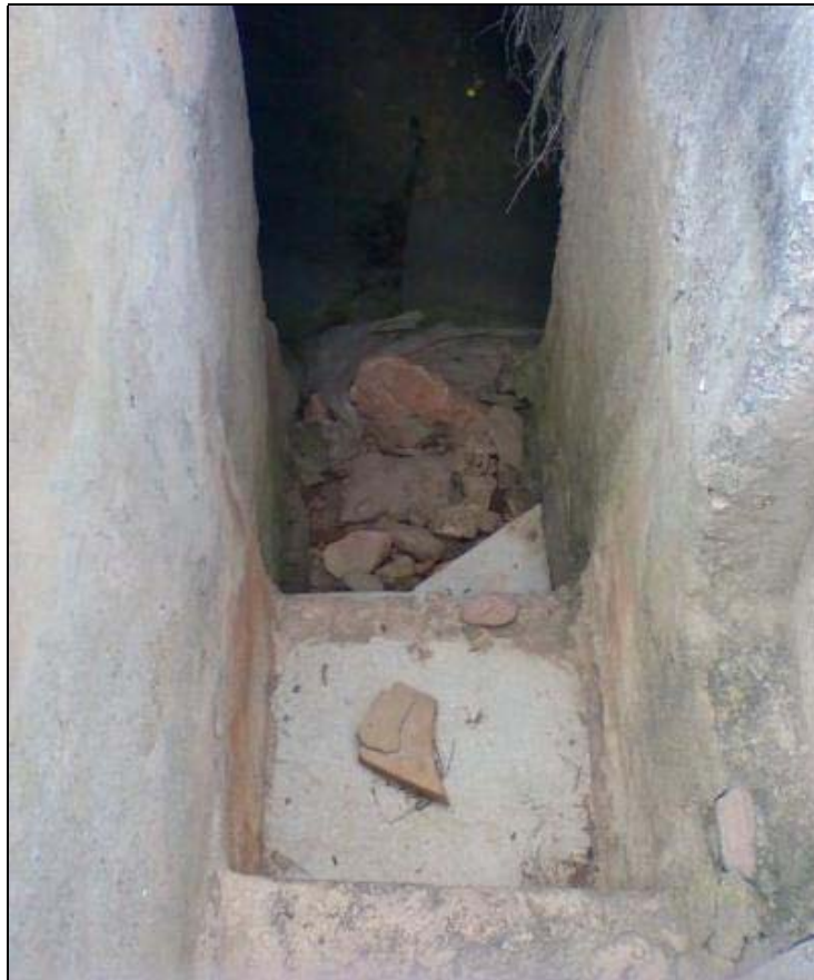
Figura 29. Manantial de la acequia de Barrina.
