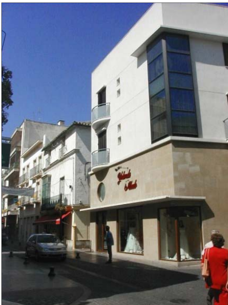
Ilustración 3. Un ejemplo de ruptura arquitectónica en pleno casco histórico.
