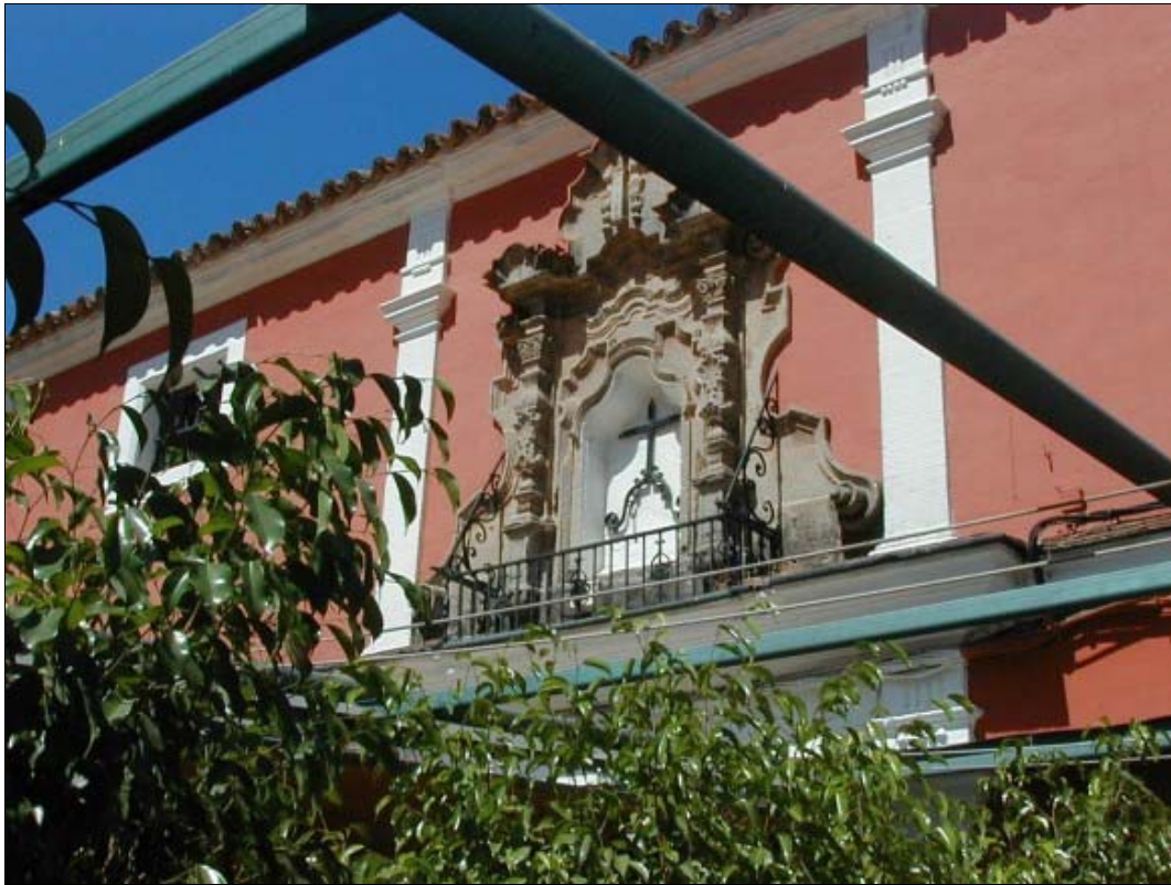
Ilustración 14. El ocultamiento de elementos decorativos es una de las consecuencias de la prevalencia de los valores mercantiles en contextos turísticos. Los toldos, y los hierros de su estructura, conforman un paisaje de producción intensiva bajo plásticos (verdaderos invernaderos) que no sólo deteriora la imagen urbana sino que mina la consideración de los vecinos hacia su patrimonio arquitectónico.
