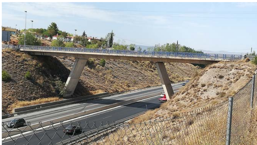
Figura 11. Puente pórico (paso superior del enlace de Loma Linda, autovía A-44, Otura, Granada). 3 vanos (15m+25m+15m)
