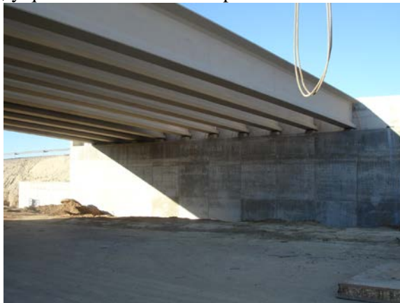
Figura 6. Puente del Enlace Este del Polígono Industrial Marchalhendín (en construcción). Emparrillado de vigas del tablero
