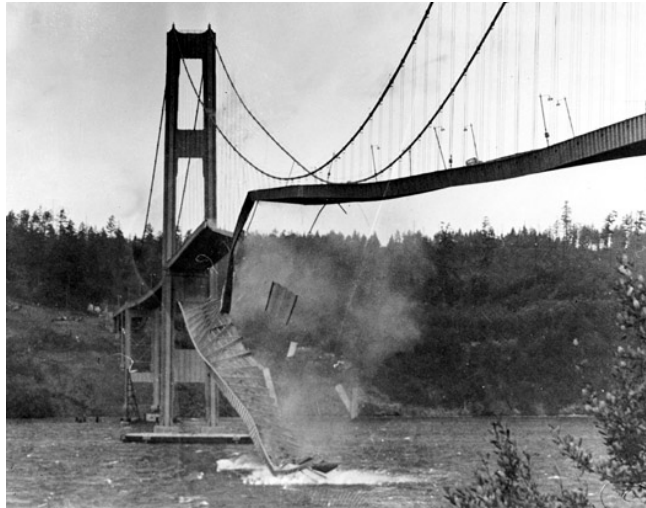
Figura 2. Colapso del puente de Tacoma Narrows en USA. Fuente: http://www.mecapedia.uji.es/vibracion.htm
