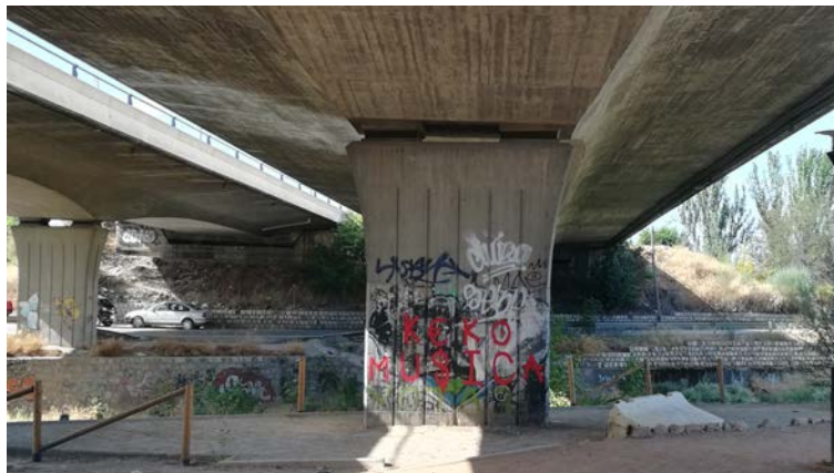
Figura 9. Puente sobre el río Genil (circunvalación de Granada). Doble apoyo de neopreno zunchado en estribos y pilas
