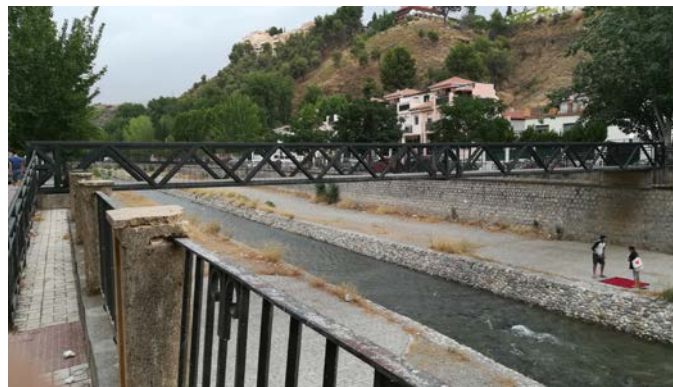
Figura 2. Puente simplemente apoyado (pasarela peatonal en camino de la Fuente de la Bicha, Granada capital). Vista longitudinal
