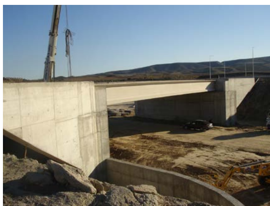
Figura 5. Puente del Enlace Este del Polígono Industrial Marchalhendín (en construcción). Tablero simplemente apoyado
