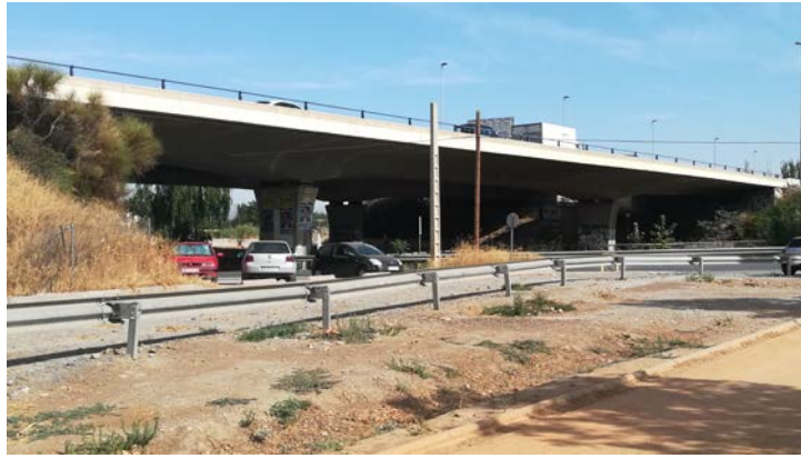
Figura 8. Puente sobre el río Genil (circunvalación de Granada). Tablero continuo de losa postensada, 3 vanos (25m+35m+25m)
