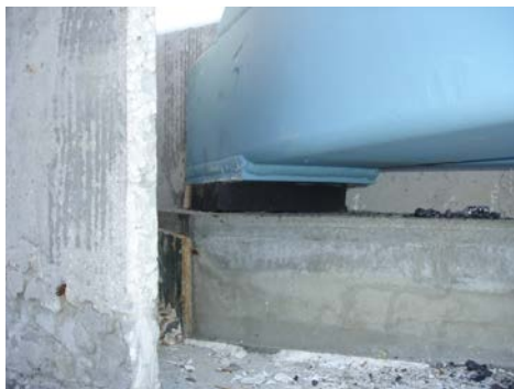
Figura 4. Apoyo de neopreno zunchado
