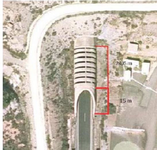
Figura 2. Fotografía aérea de una pérgola en la entrada de un túnel en Lorca.
