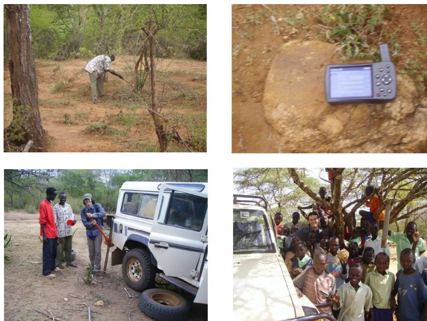
Figura 1.- Proyecto de Construcción de Presa en Amkuriat (Kenia). ONG: Calor y Café Alumno: Manuel Dávila
