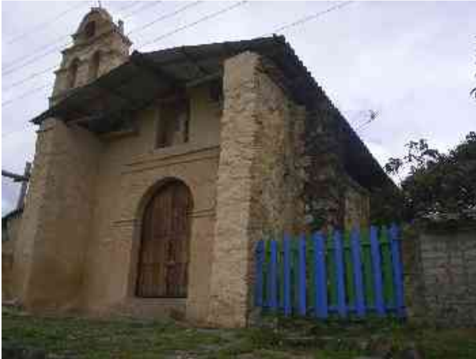
2. EXTERIOR DE LA IGLESIA DOCTRINERA DE TAUSA VIEJO. DEPARTAMENTO DE CUNDINAMARCA.
