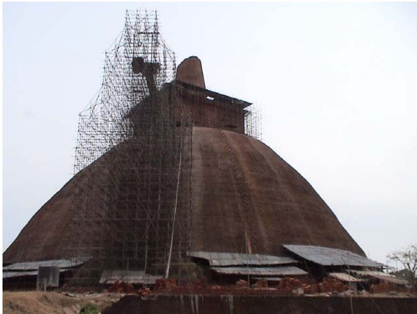
Fig. 4. El stupa de Jethavarama construido a principios del SIV (206-303 D.C.), el mas grande del mundo con una altura de 130 m. y cerca de 93 millones trescientos mil ladrillos.
